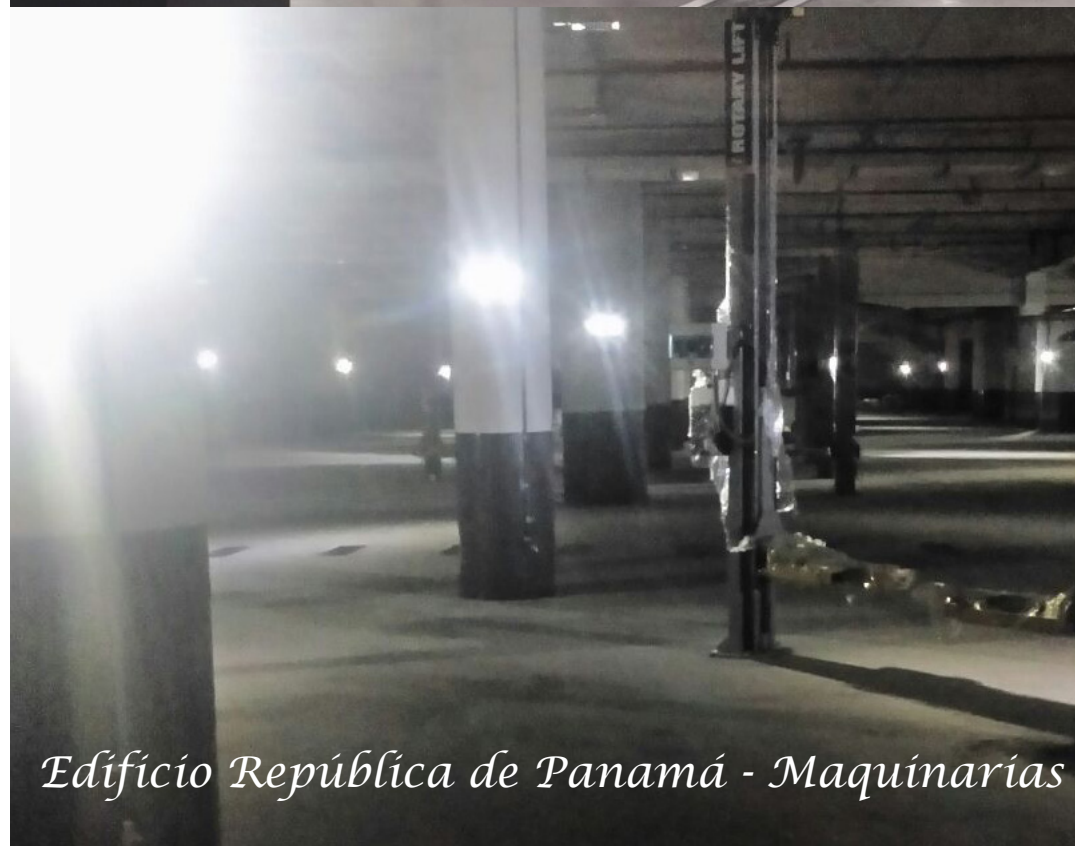
Edificio República de Panamá - Maquinarias
